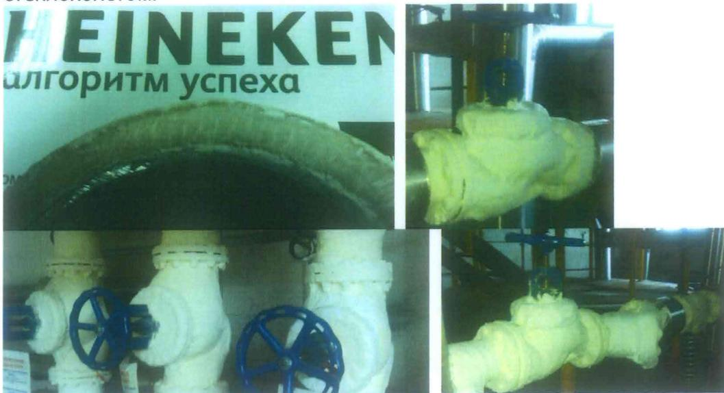
За 8 месяцев эксплуатации мы увидели уникальные теплоизолирующие свойства материала изоляции, так при температуре пара в стальной трубе +140 градусов Цельсия, на поверхности изолированной трубы и на поверхности изолированной запорной арматуры, температура не более 42 градусов Цельсия.
