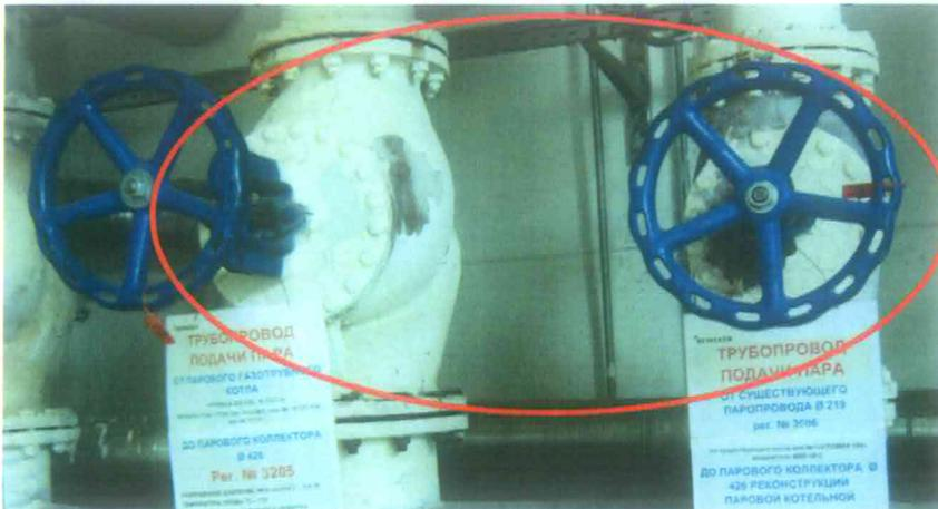
Особенно хотим отметить возможность нанесения изоляционного материала, без остановки паропровода, и очень короткий срок устройства изоляции, что имеет важное значение в условиях непрерывного производственного цикла.
